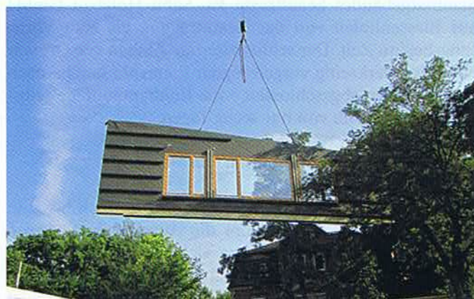
Bild 3. Die Bauzeit vor Ort dauerte gerade einmal zehn Wochen – noch vor Vorlesungsbeginn konnte das Gebäude schlüsselfertig an den Bauherrn übergeben werden
