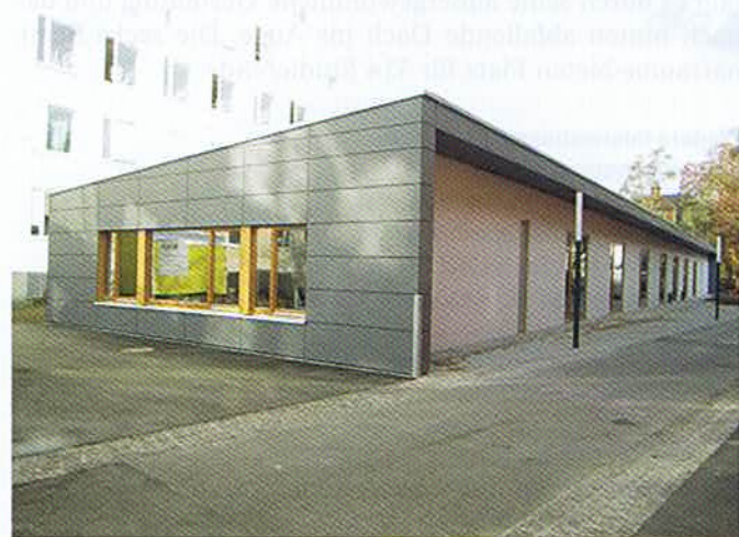
Bild 1. Um mehr Platz für die Studierenden zu schaffen, errichtete die Fa. Säbu Holzbau in von nur fünf Monaten ein neues Seminargebäude in Holzbauweise für die Friedrich-Alexander-Universität Erlangen-Nürnberg
