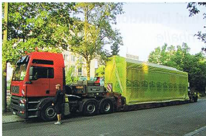
Bild 2. Das Gebäude wurde in Form von 12 m langen und 4 m hohen Bauelementen im Werk industriell vorgefertigt und anschließend per LKW zur Baustelle transportiert
