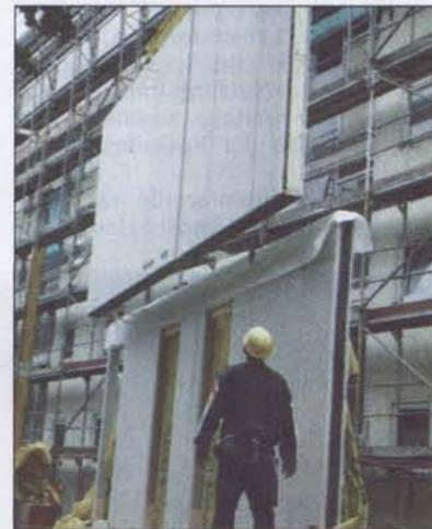
Industriell vorgefertigte Wandteile werden passgenau montiert
