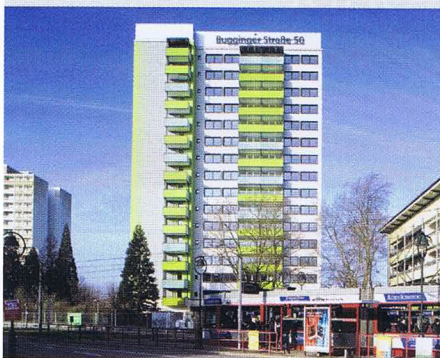
Vorreiter unter seinesgleichen beim Energiesparen: Das erste auf Passivhausstandard sanierte Hochhaus der Welt in Freiburg-Weingarten.
