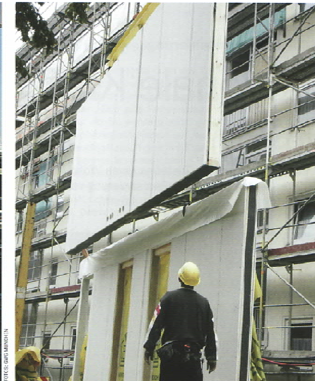
Mit einem Kran werden die im Werk der Firma Säbu Holzbau vorgefertigten Wände und Decken auf die fünfte Etage gehievt
